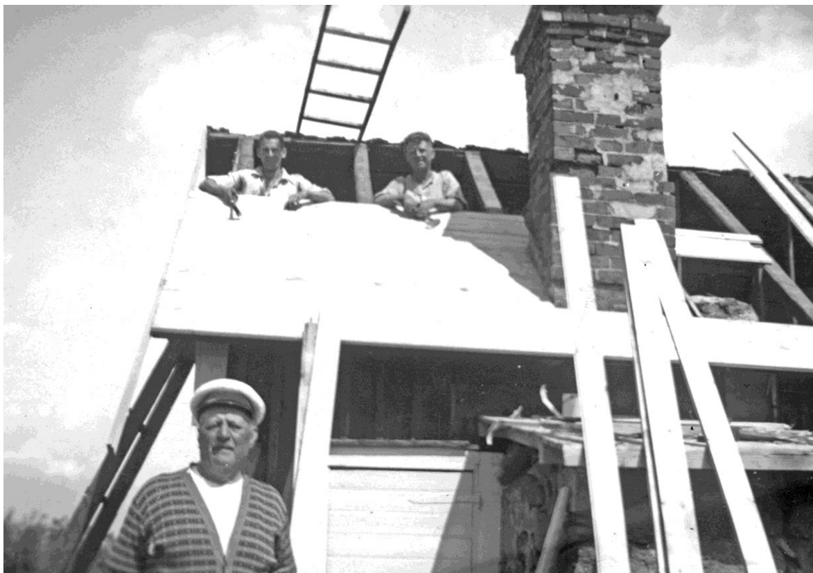
Taket behövde förbättras. Närmast fader Axel, ovan Allan och Calle.
