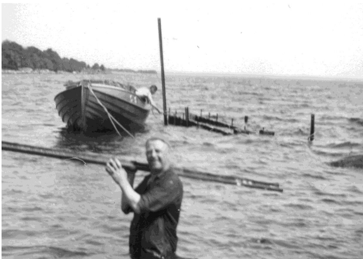
Calle och Allan bygger ny stenbrygga till båten.
